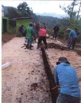
Foto1: Se observa la construcción de los cimientos que sostendrán la nueva estructura.
