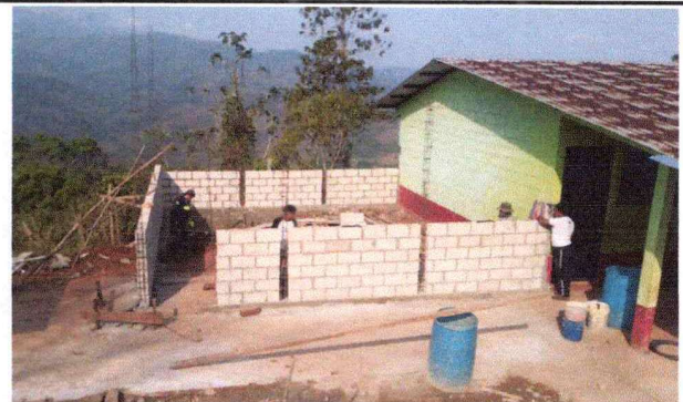
Foto 4: Se observa el salón en proceso de remozamiento.
