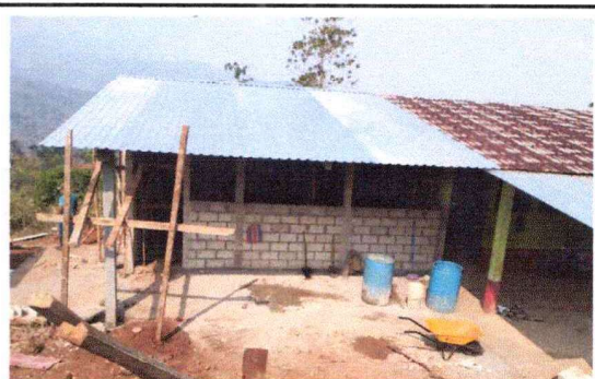
Foto 6: Se observa la estructura de entechado realizada.
