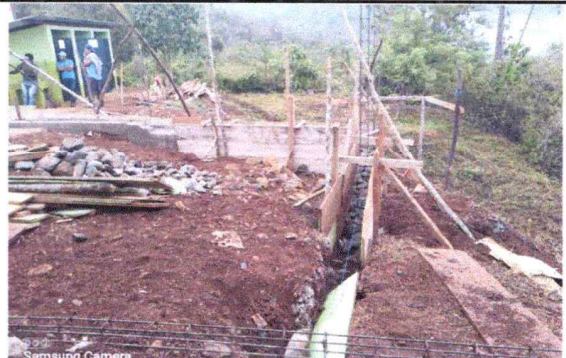
Foto 2: Etapa de fundición de los cimientos.
