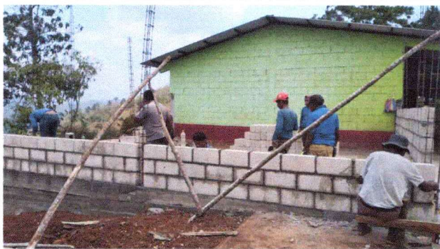
Foto 3: Construcción de paredes con block de poma.
